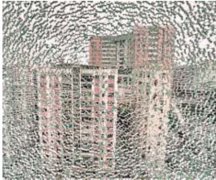
Imagen 1 . Patrón de rotura típica por rompimiento espontáneo.
